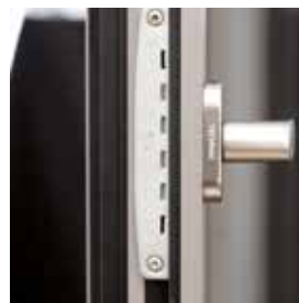
Maniobra de los cierres por cremona encastrada bidireccional
